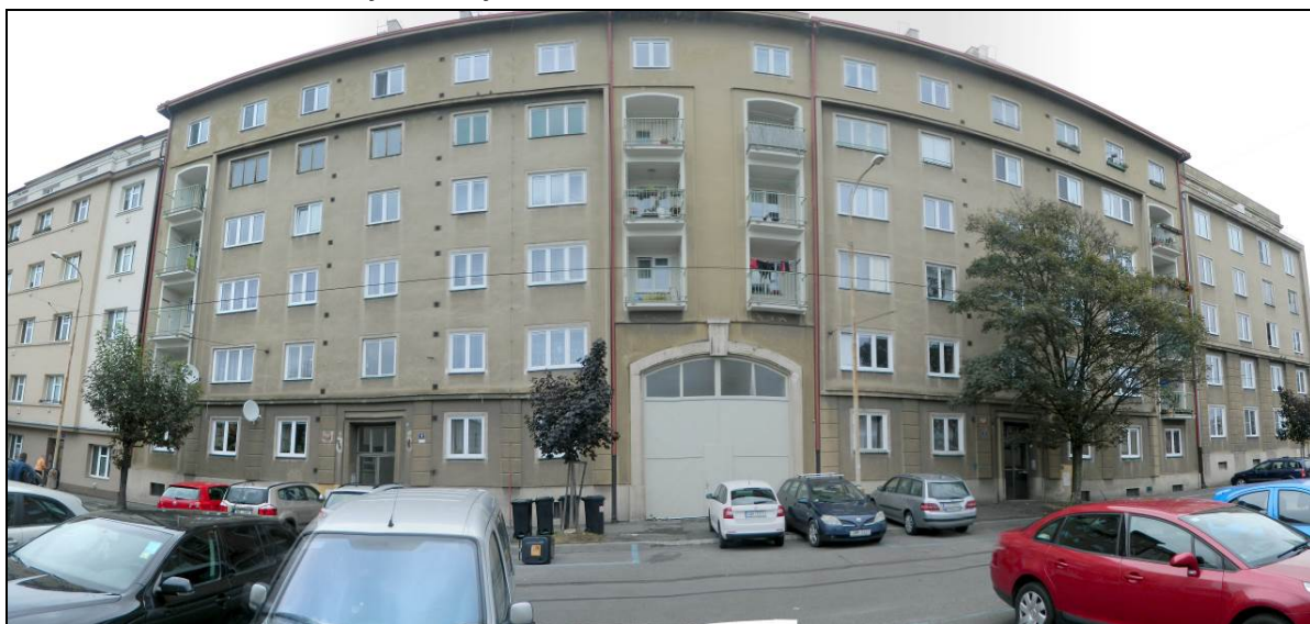
Loudova – fasáda západ (do ulice)
