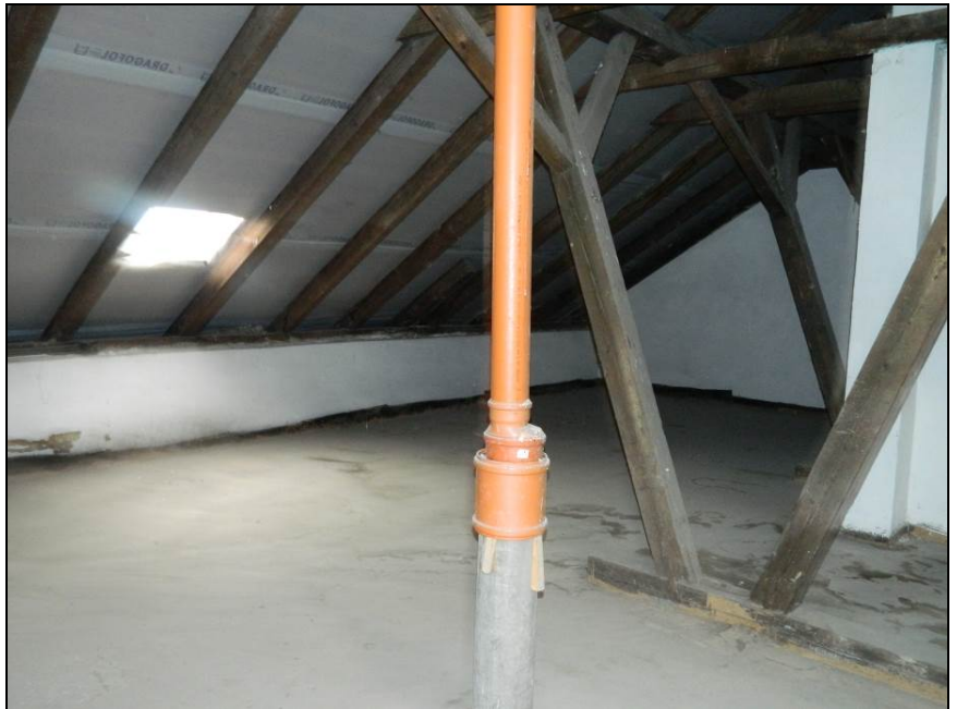
Půda, krov a strop nad posledním podlažím
