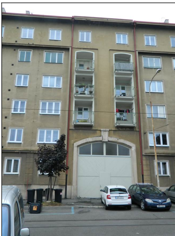
západní fasáda do ulice – střední část s průjezdem
