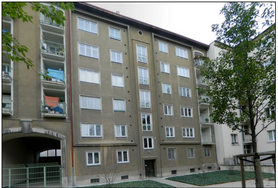
Fasáda východní – do dvora
